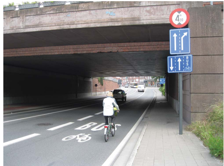
Foto 14: Fietsers en bussen delen de busbaan in de Zandstraat t.h.v. spooronderdoorgang
