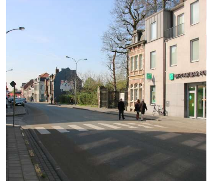
APPARTEMENTEN EN BANKKANTOOR LANGS DOORNIKSEWIJK
