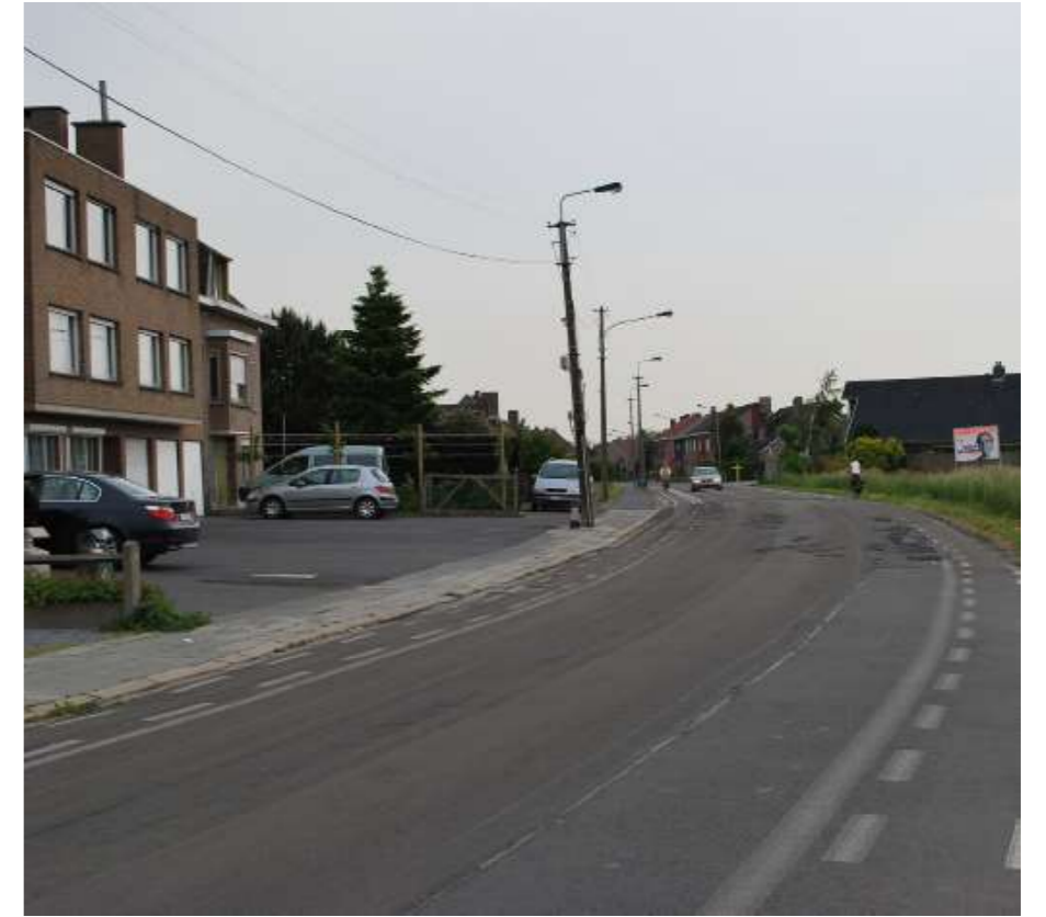
3. DE BOZESTRAAT, TER HOOGTE VAN KRUISSING MET N50 (KIJKRICHTING OOSTEN)
