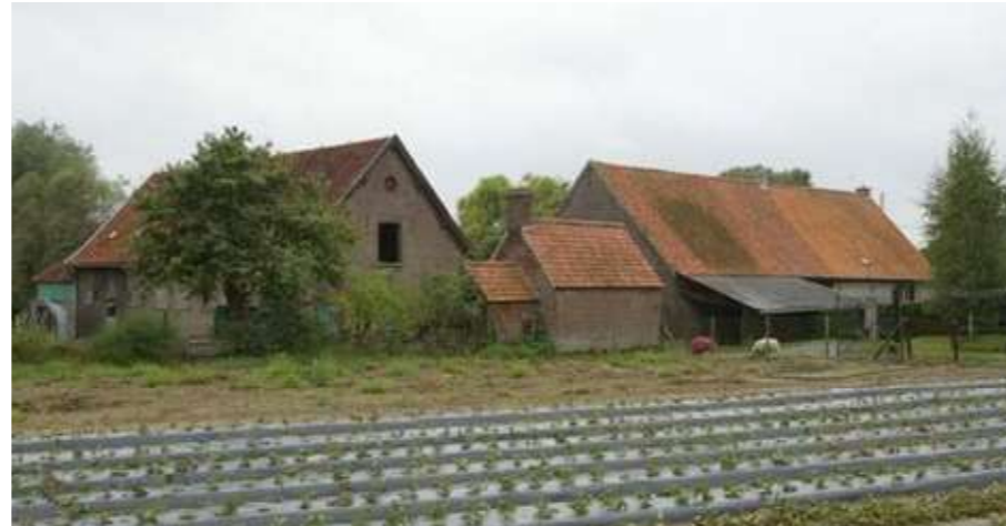
Bron : Inventaris bouwkundig erfgoed, foto Kris Vandevorst, 10.09.2003
