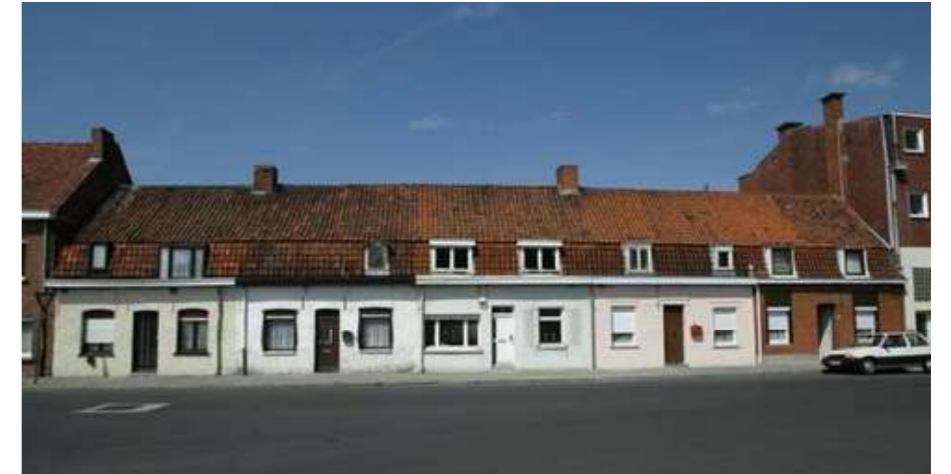
Bron : Inventaris bouwkundig erfgoed, foto Kris Vandevorst, 14.08.2003
