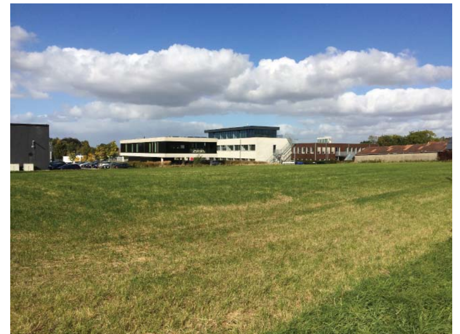
Zicht vanuit de Liefdeweg naar de achterzijde van kantoorgebouwen van het Beneluxpark
