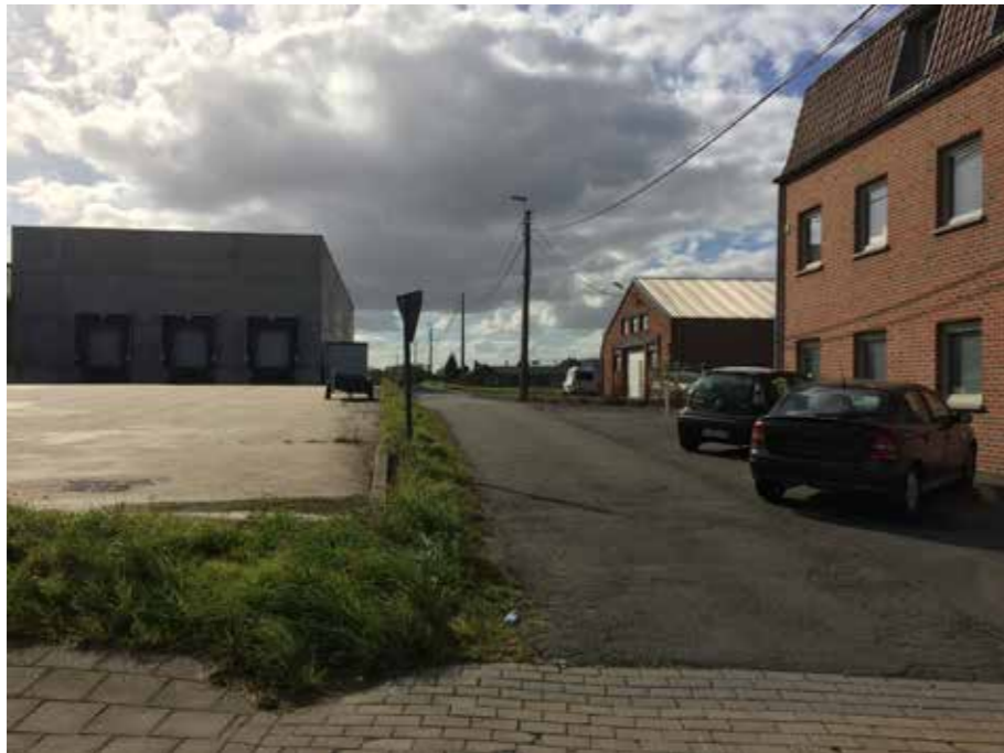
ZICHT OP DE INRIT VAN DE LIEFDEWEG VANUIT DE GEWESTWEG N50 'T HOGE, MET LINKS EEN VERLATEN BEDRIJFSGEBOUW EN RECHTS STUDENTENHUISVESTING
