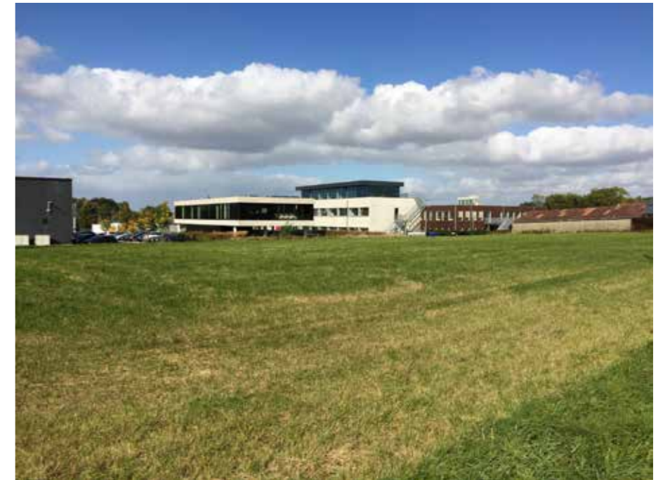
ZICHT VANUIT DE LIEFDEWEG NAAR DE ACHTERZIJDE VAN KANTOORGEBOUWEN VAN HET BENELUXPARK
