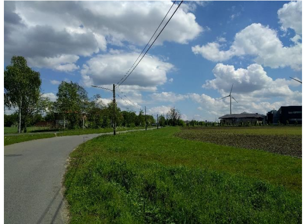
Foto 10: Weginfrastructuur Kapel ter Bede
