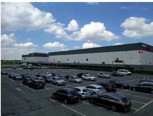
Foto 38: Kortrijk Xpo hallen 4 en 5 t.h.v. parking 7
