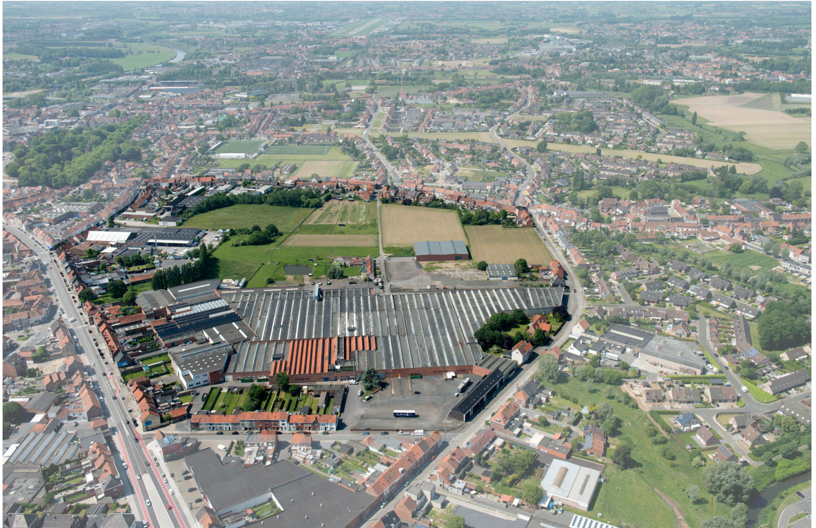
luchtfoto site Mewaf (2015)
