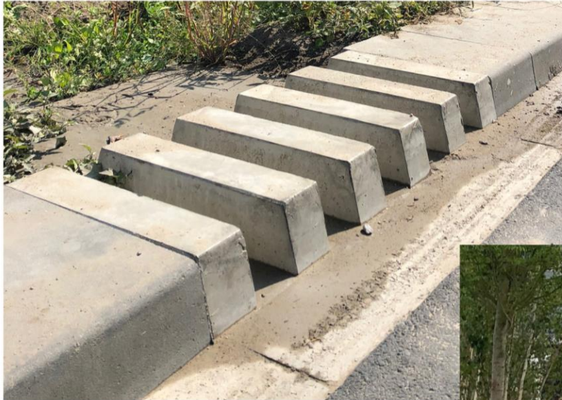
brede, geperforeerde betonboordstenen
