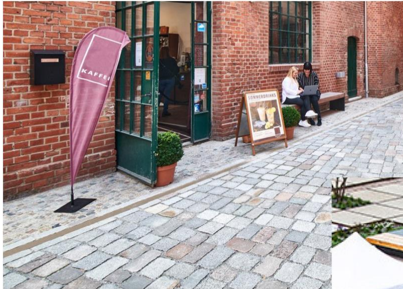
randen in kasseien/platines geïntegreerde aanduiding grens publiek/privaat en putdeksels
