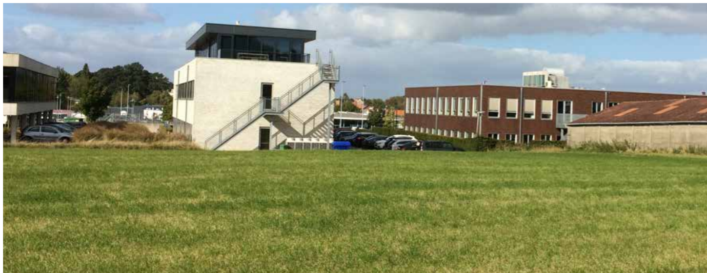
Niveaoverschil tussen omgeving Beneluxpark fase 2 (onbebouwde gronden langs Liefdeweg) en de kantorenstrip op Beneluxpark fase 1
