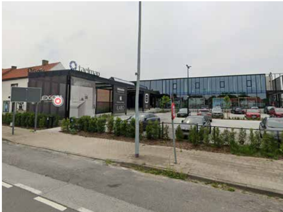
Zicht op de nieuwe vestiging van Elektro Taelman, langs 't Hoge, op de voormalige site van het bedrijf Visalux
