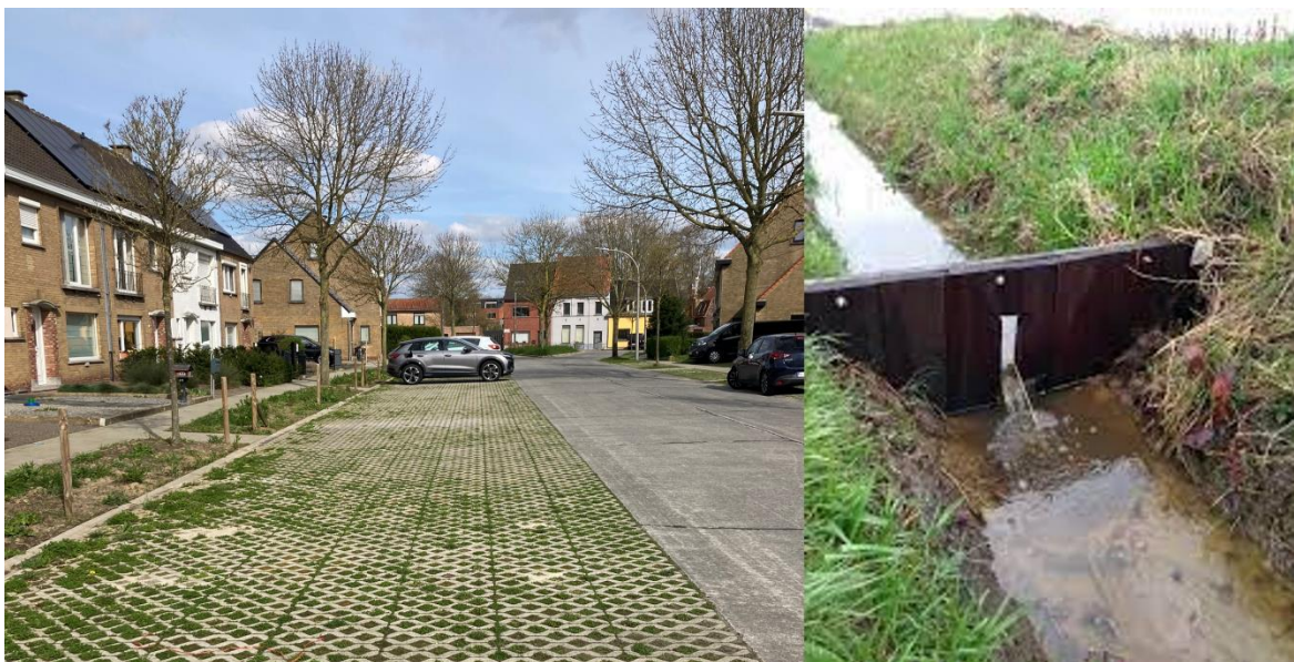
Figuur 6. Voorbeelden van mogelijke maatregelen om afstroom te vermijden van (Links) verharde oppervlaktes (Rosa Laperelaan, Kortrijk) en (Rechts) het plaatsen van (knijp)stuwen in afvoergrachten.
