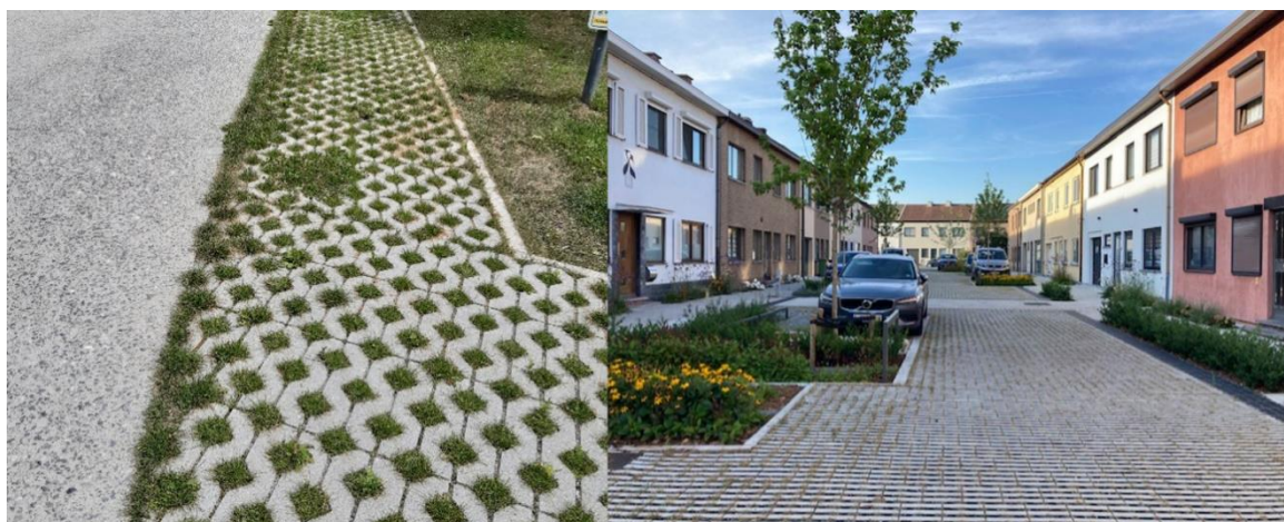
Figuur 25: Vlnr: (1) Versmald voet-fietspad met uitwijkmogelijkheid over waterdoorlatende verharding (Overijse). © Aquafin; (2) Tuinstraat met zowel rijweg als parkeervakken aangelegd in halfverharding (Aziëlaan, Wilrijk). © Aquafin.
