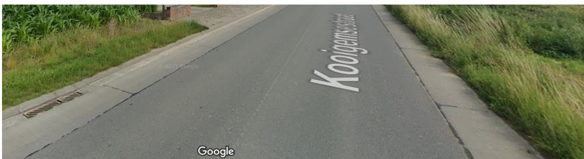
Figuur 24. Kooigemsestraat. Deze kan worden afgekoppeld door de straatkolken dicht te maken en het regenwater in de berm te laten infiltreren. Bron: Google Maps.
