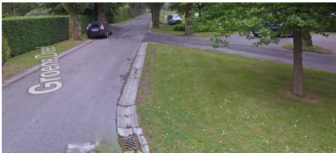
Figuur 19. Groenzone in de Groene Dreef. Momenteel wordt deze omringd door een goot met straatkolk, en ligt deze lichtjes hoger dan de straat, waardoor water van de straat rechtstreeks via de straatkolk zal worden afgevoerd en niet de kans krijgt om te infiltreren in de groenzone.
