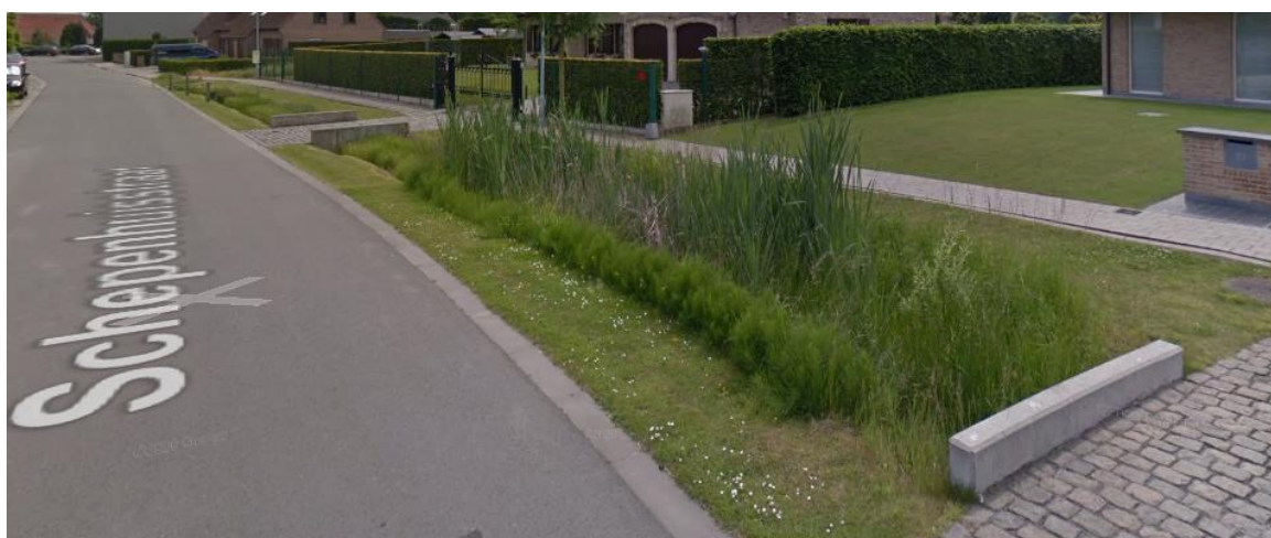
Figuur 22. Bestaande infiltratie- en buffervoorziening in de Schepenhuisstraat.
