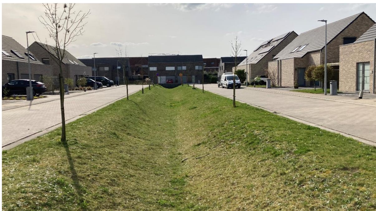
Figuur 32. Voorbeeld van verlaagd aangelegde groenzone in de woonwijk Hof ter Melle in Kortrijk. Om deze groenzones nog optimaler in te zetten, zouden de straatkolken kunnen worden afgesloten (met een overloop in de groenzones zelf).
