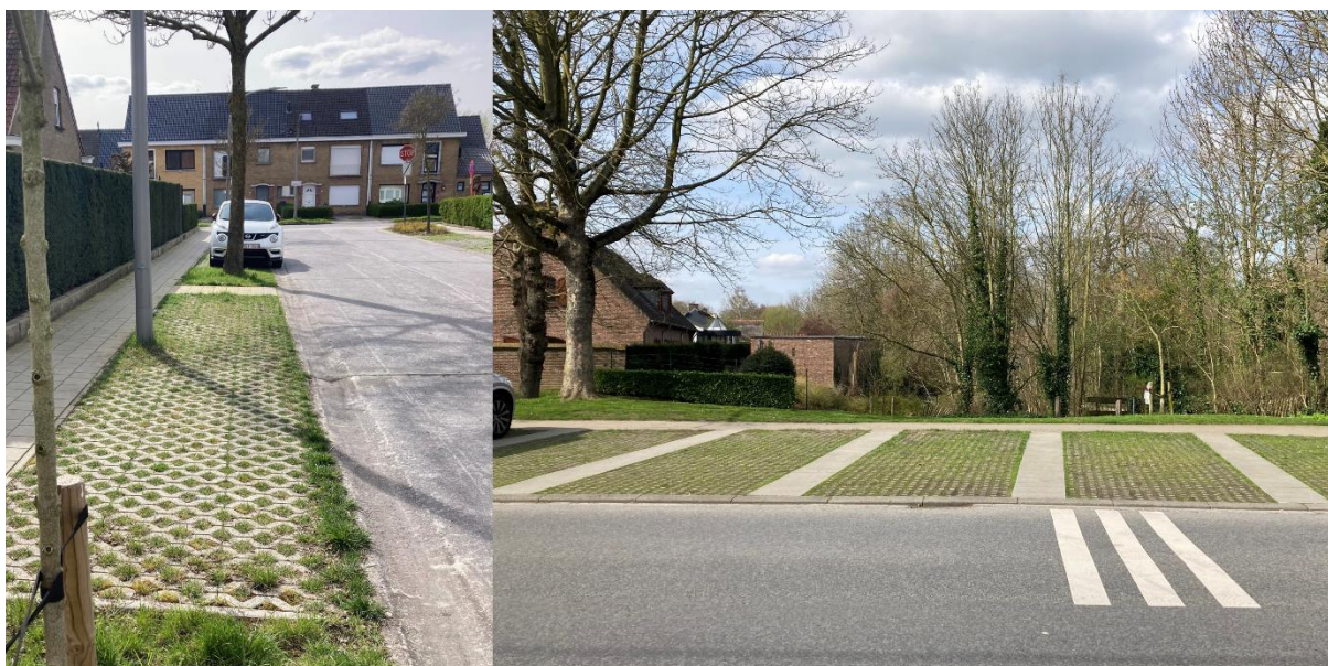
Figuur 29. Parkeerplaatsen op openbaar domein in halfverharding (grasbetontegels) in (links) Rosa Laperelaan en (rechts) Peperstraat in Kortrijk.
