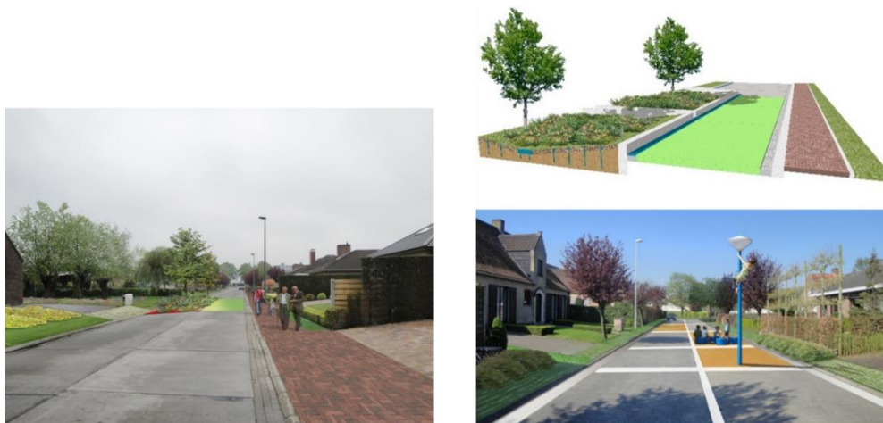
Figuur 17. Sfeerbeelden uit het participatietraject in de wijk Kroonhove in Oostkamp. De vorm van de betonplaten werd gebruikt als structurend element voor de nieuwe "plaatinvullingen". Bouwheer: Gemeente Oostkamp - Studiebureau NERO architectuur en stedenbouw en landschapsarchitect Denis Dujardin.
