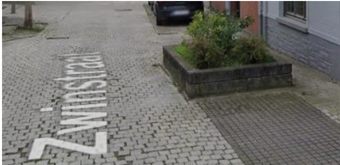
Figuur 18. Verhoogd plantvak in de Zwijnstraat, dat niet bereikbaar is voor regenwater uit de omgeving. Deze straat staat op de planning voor heraanleg.
