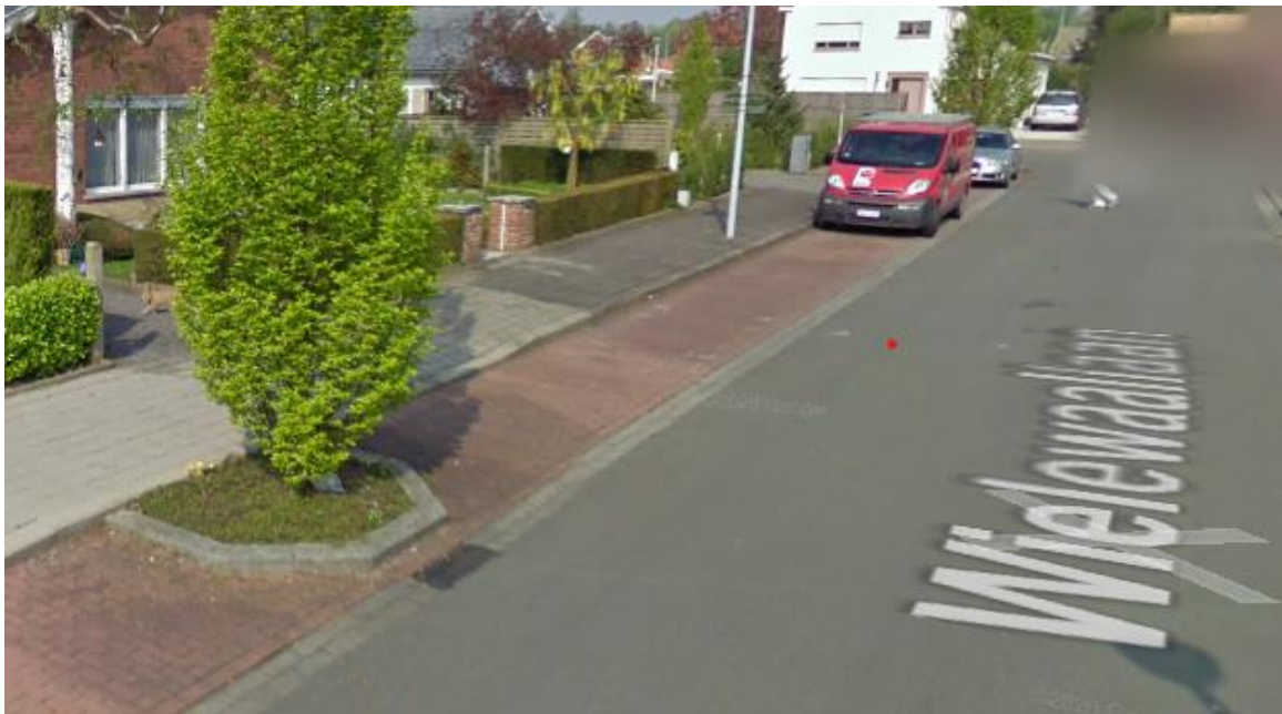
Figuur 20. Boomvak in de Wielewaallaan dat volledig is omzoomd met een drempel en dat wordt vooraf gegaan door een straatkolk. Aanpalend bevindt zich een parkeerstrook. Wanneer verlaagd en toegankelijk ingericht kunnen de boomvakken worden ingeschakeld om regenwater van de parkeervakken en straat te bergen en (vertraagd) te infiltreren.
