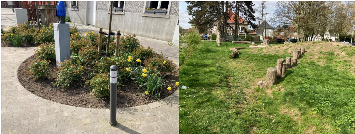
Figuur 7. Voorbeelden van infiltratievoorzieningen in Kortrijk. Links) Plantvak zonder borduur op de Heuleplaats waar afstroom aanpalende verharding in kan infiltreren en Rechts) verlaagde speelzone op het Pieter Pauwel Rubensplein.
