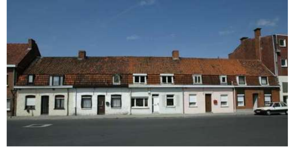
Bron : Inventaris bouwkundig erfgoed, foto Kris Vandevorst, 14.08.2003
