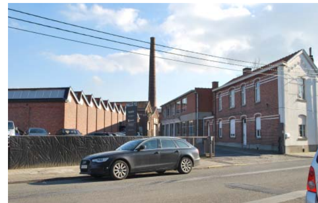
VOORMALIGE TAPIJTWEVERIJ BIC MET LINKS VOLUME MET SHEDDAKEN EN RECHTS DE CONCIËRGE- EN DIRECTEURSWONING
