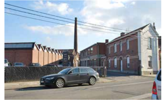
VOORMALIGE TAPIJTWEVERIJ BIC MET LINKS VOLUME MET SHEDDAKEN EN RECHTS DE CONCIËRGE- EN DIRECTEURSWONING
