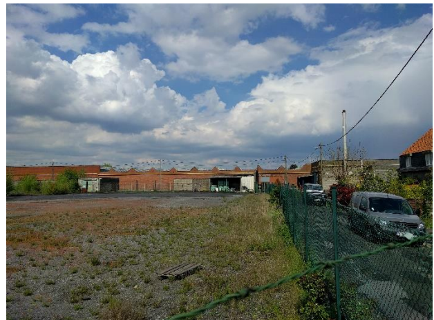
Foto 19: Van Marcke-bedrijfsite tegenover woningen met achterliggend bedrijfsgebouwen
