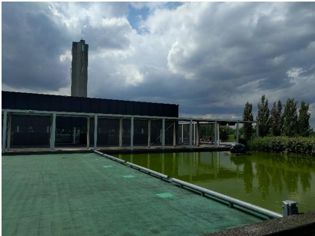
Foto 34: Hallen Kortrijk straatzijde Doorniksesteenweg
