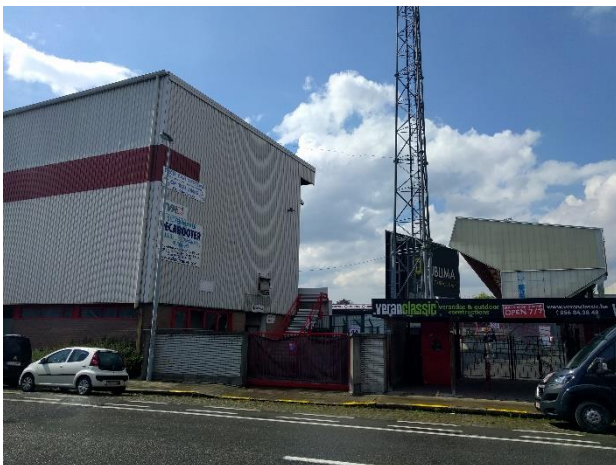
Foto 5: Zuidelijke en oostelijke tribunes met toegang vanaf de Meensesteenweg
