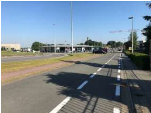
Figuur III-20: Fietspad t.h.v. rotonde 't Hoge.
