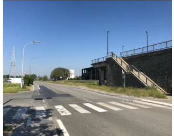
Figuur III-12: Voetgangers-/fietsersbrug in verlengde Luipaardstraat t.h.v. Kanaal Bossuit-Kortrijk.
