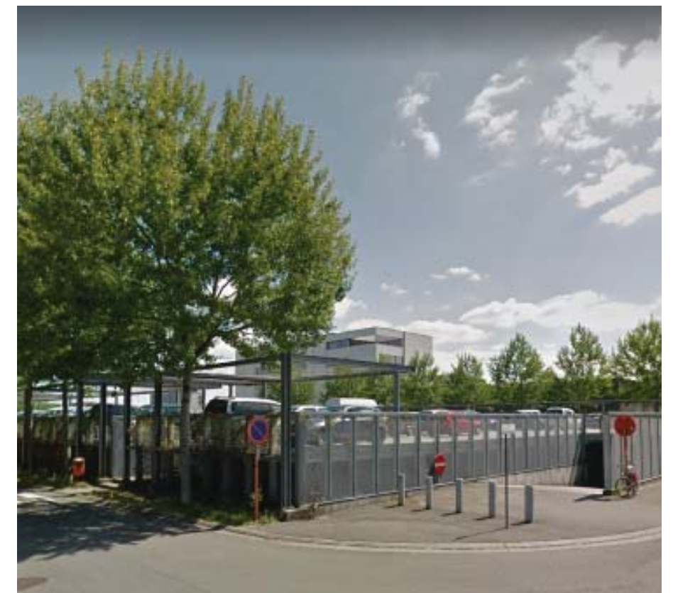
PARKEERGEBOUW ARBEDSITE GENT
