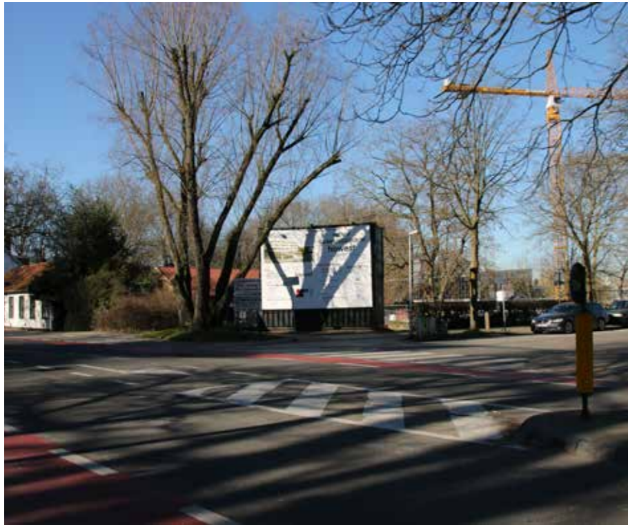
KRUISPUNT MARKSESTEENWEG – GRAAF KAREL DE GOEDELAAN: BESTAANDE TOESTAND
