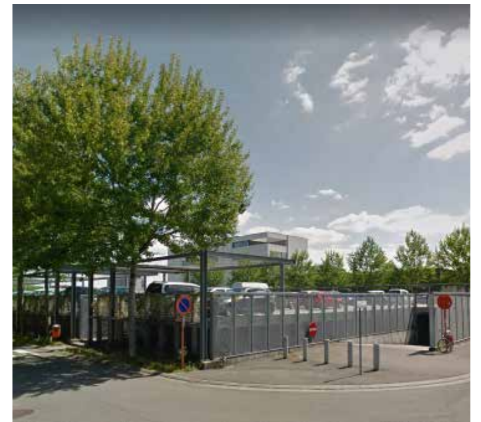
PARKEERGEBOUW ARBEDSITE GENT
