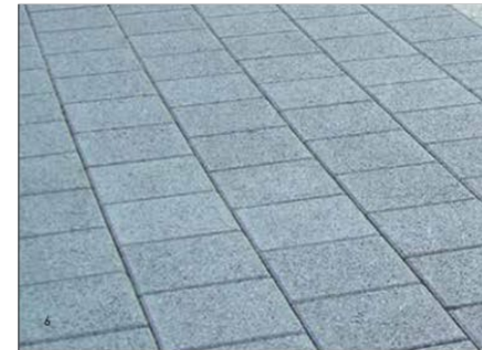
Voetpad-stoep: betonstraatstenen vierkant
