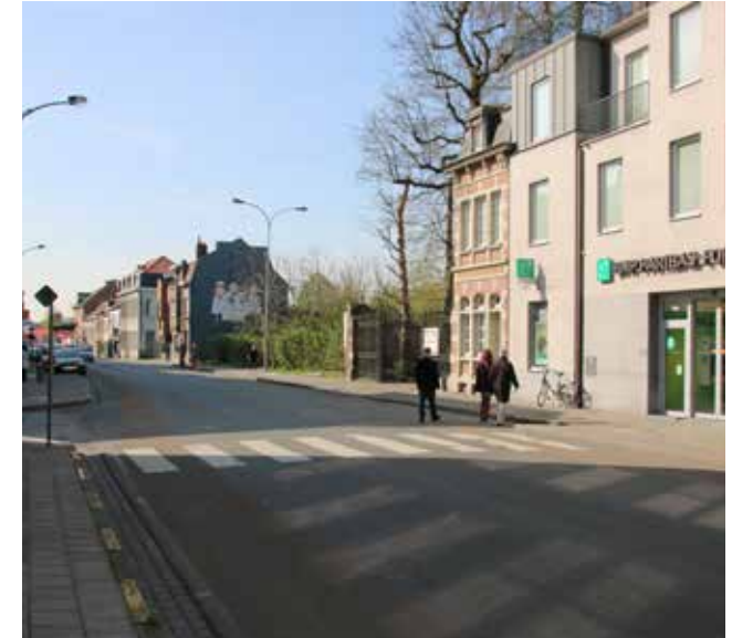
APPARTEMENTEN EN BANKKANTOOR LANGS DOORNIKSEWIJK
