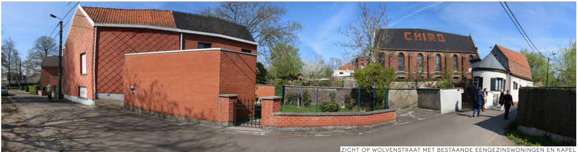
ZICHT OP WOLFENSTRAAT MET BESTAANDE EENGEZINSWONINGEN EN KAPEL
